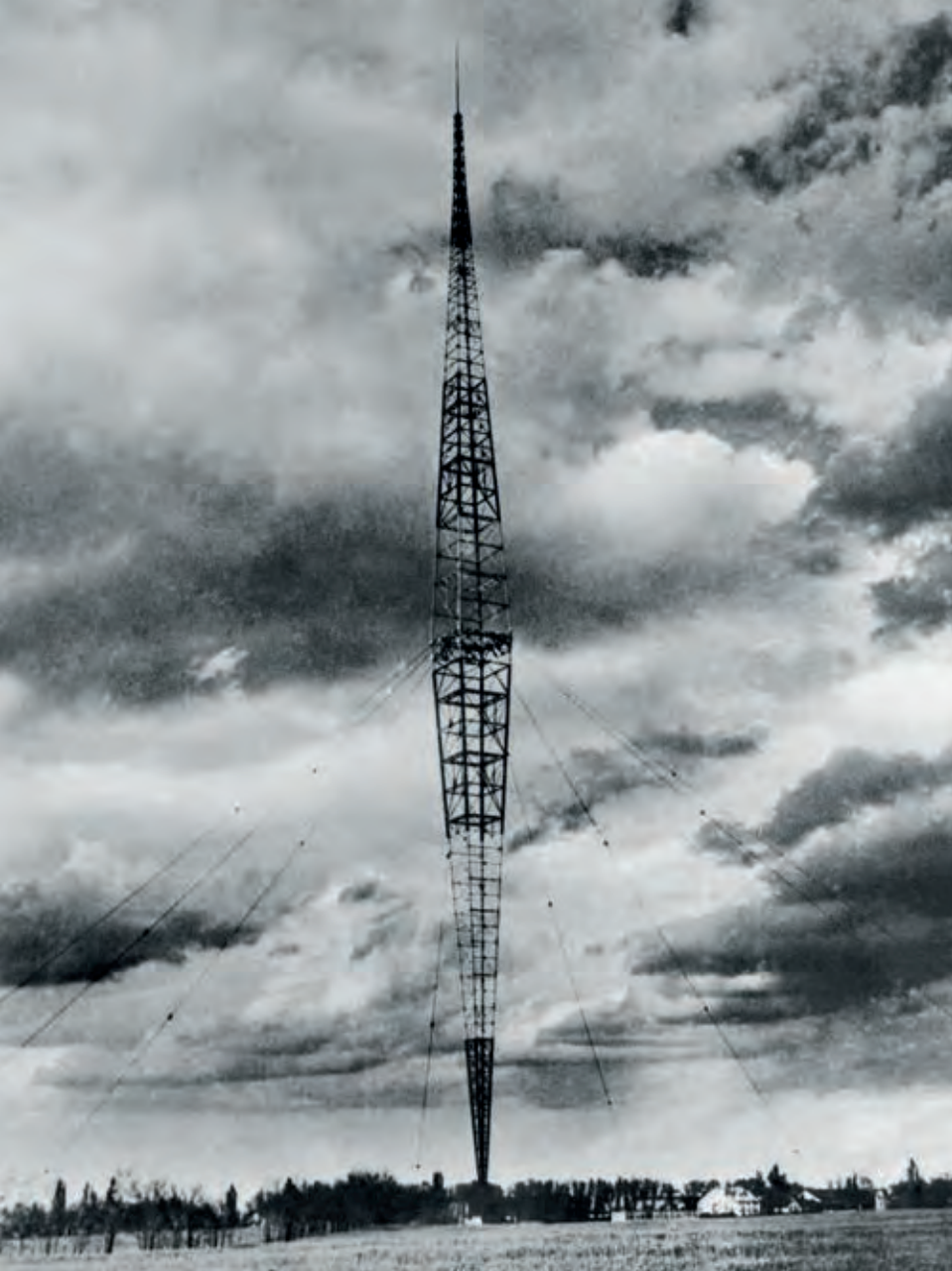
Lakihegyi rádióállomás, a 314 m magas Blow-Knox rendszerű antenna. Forrás: postamuseum.hu
